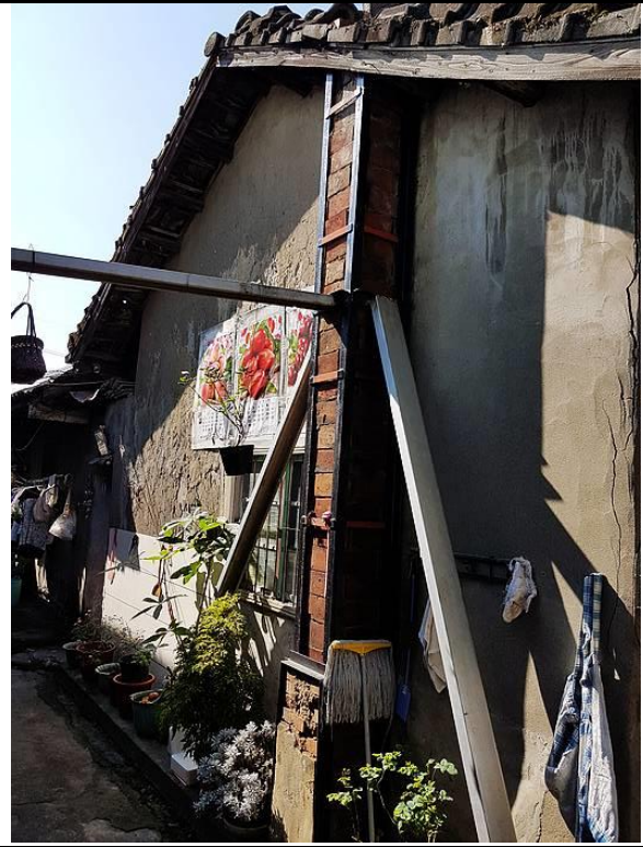
外牆以鋼架臨時支撐
