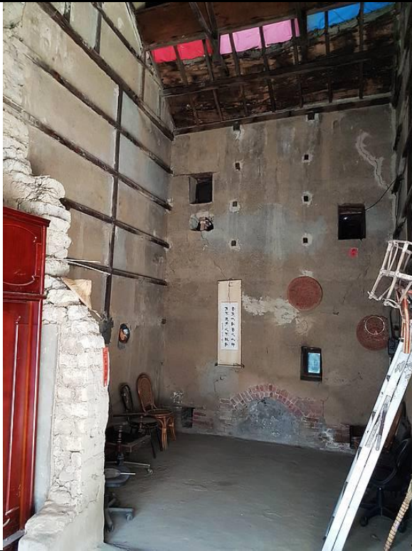
菸樓內牆面因 921 大地震而倒塌
